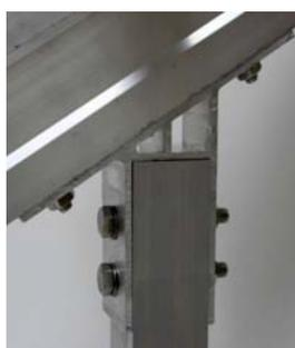
Detalle unión pata-viga
